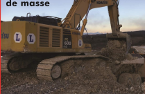
Terrassement de masse
