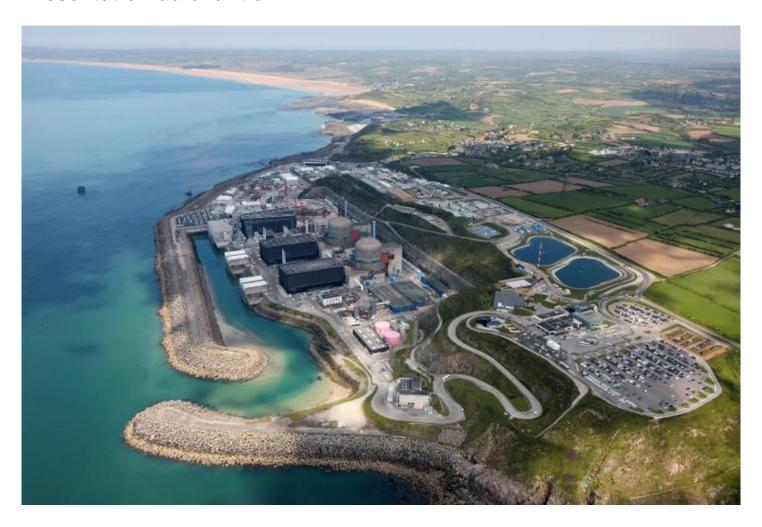
La centrale nucléaire de Flamanville possède 2 réacteurs à eau pressurisée de 1 300 MWe. EN 2023, elle a produit en moyenne 11,7 TWh d'électricité faible en CO<sub>2</sub>, soit l'équivalent de la consommation électrique de 5,3 millions d'habitants.
